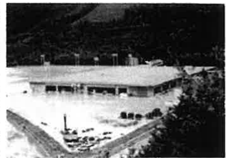
本川根中学校付近の工場
